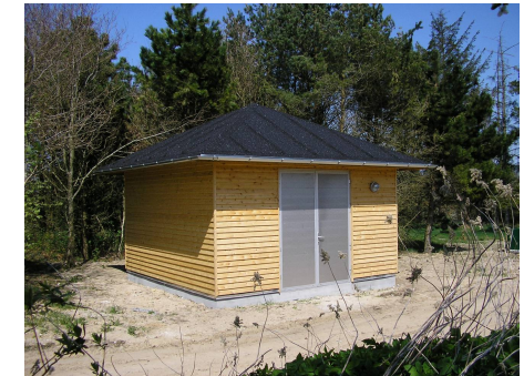
Vandværket på Stendalsvej
